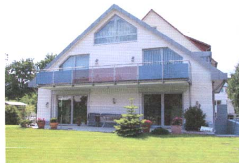
Foto 2 Neubau als Anbau von der Ostseite aus
