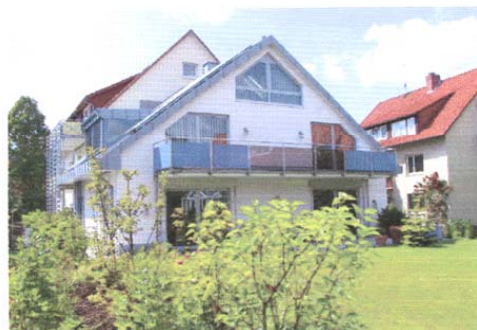
Foto 1 Neubau als Anbau von der Ostseite aus
